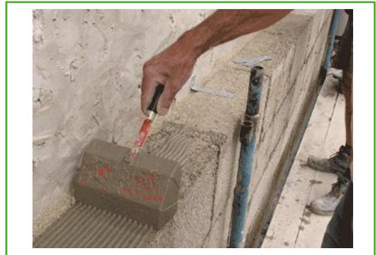
Il legante che costituisce la malta è una calce idraulica ottenuta dalla calcinazione, a bassa temperatura (850-900°C circa), di calcari puri e pozzolane naturali; ciò rende l'impasto particolarmente aderente, elastico, altamente resistente alle aggressioni alcaline e alla formazione di agenti micotici.
